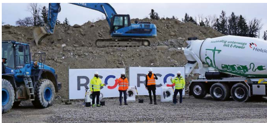
Der Verwaltungsrat der RCO beim Spatenstich für die neue Baustoffrecyclinganlage am 29. Januar 2021, von links: Stefan Eberhard, Karin Steiner, Roland Keller, Niels Albrecht.
