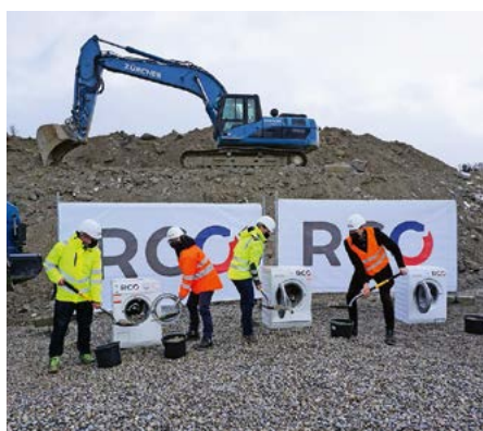
Die RCO wäscht den mineralischen Bauabfall: Symbolischer Auftakt zum Bau der modernsten Baustoffrecyclinganlage der Ostschweiz.
